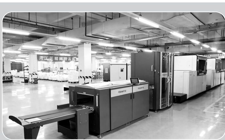
盛通股份引入高清彩色喷墨印刷机,打造数码印刷车间。
