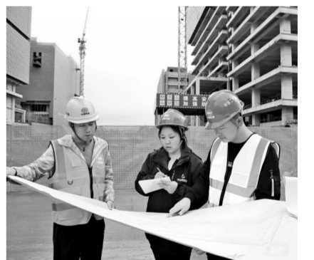
10月1日，李寒梦（中）抵达河北廊坊固安高新区高端医药与健康产业园的标准化厂房施工现场采访。
